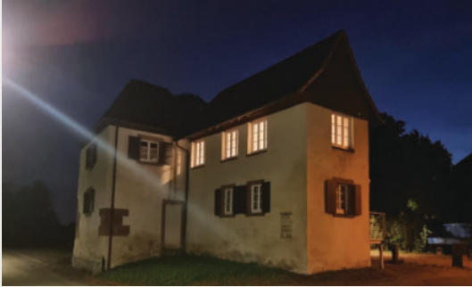
Im Wehrturm befindet sich das Vereinsbüro
