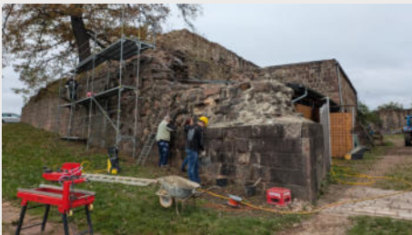
Sanierung Mauerwerk
