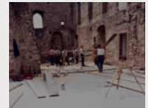
Arbeiten an der Betondecke, 1976
