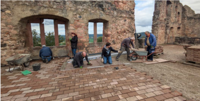
Sanierung der Decke über Bau B, 2024
