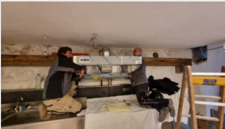
Arbeiten in der „Neue Küche“
