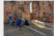
Ausrichtung der Höhe des Splittunterbaus, 2024
