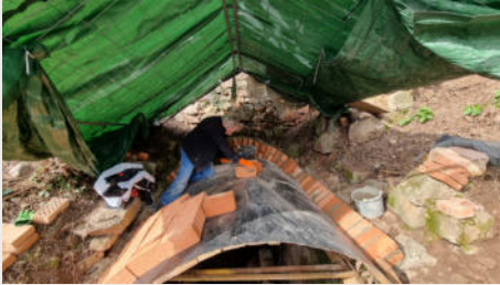
Sanierung Mauerwerk
