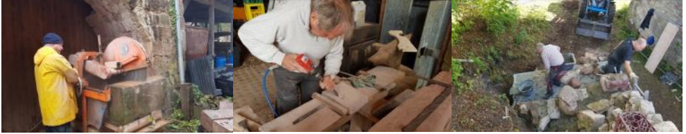
Maschinelle Bearbeitung und Transport der Steine mit Schlepper, auf der Hochburg
