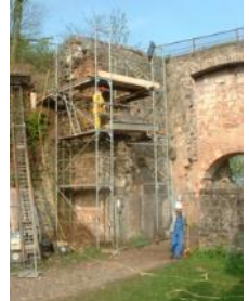
Verkehrssicherungsarbeiten am Haupttor
