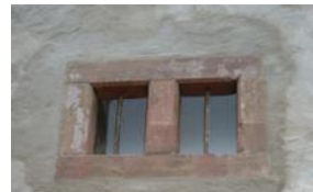
Neues Fenster am Schneckenkasten
