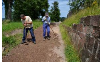
Auswaschungen reparieren
