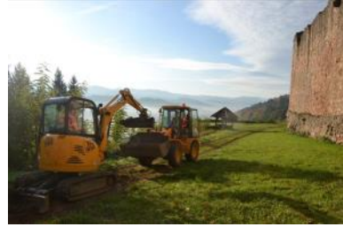
Wegebau durch den Bauhof
