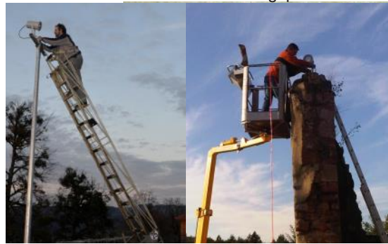
Installation der Strahler
