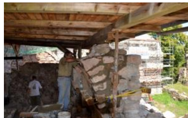
Reparatur der Gewölbereste
