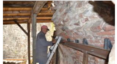
Montage des Abfangträgers
