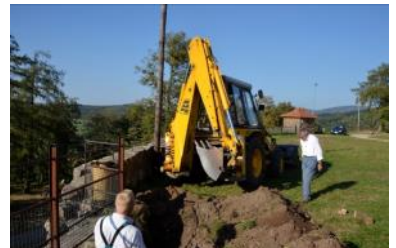
Graben für Beleuchtung
