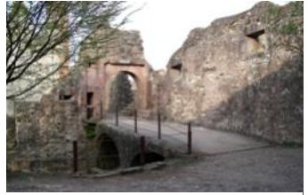
Haupttorbrücke - neues Geländer
